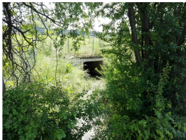
Foto 09033. Attraversamento A27 del capofosso principale.
