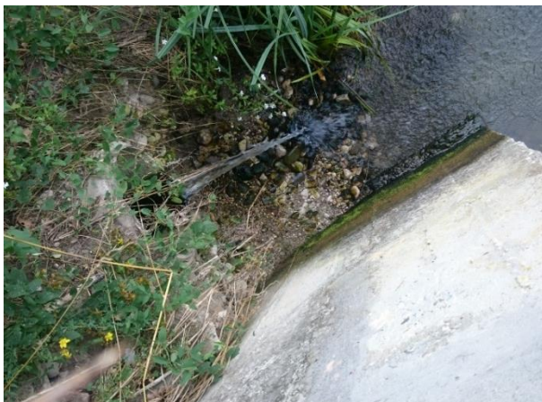
Foto 17051. Scarico della condotta proveniente da via Alzaia sul Sile.
