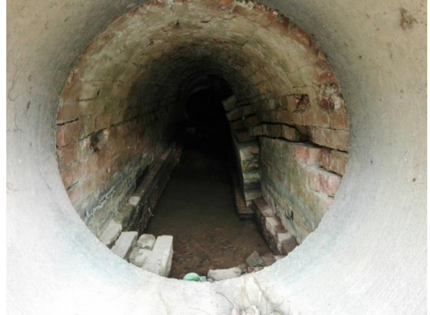
Foto 06388. Attraversamento via Montiron.
