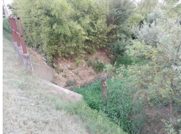
Foto 11039. Canale Pentia. Attraversamento di via Pozzetto lato sud.
