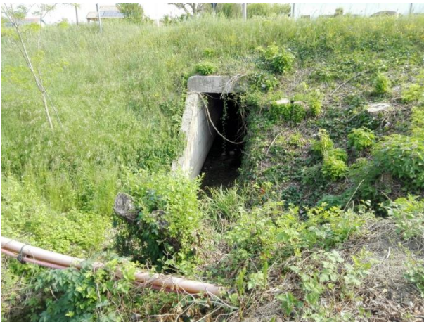
Foto 08063. Attraversamento via Cendon lato sud.
