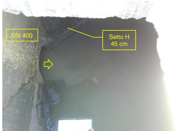
Foto 13021. Manufatto di sfioro lato nord.
