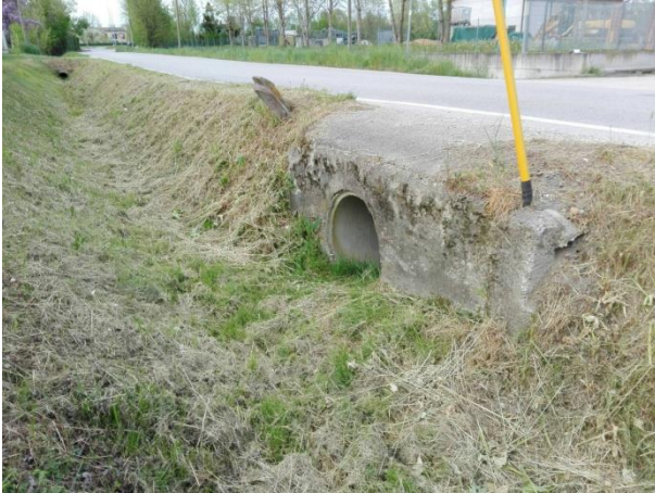
Foto 06387. Inizio capofosso, attraversamento via Montiron.
