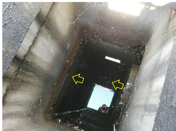
Foto 14148. Pozzetto con sifone di attraversamento.
