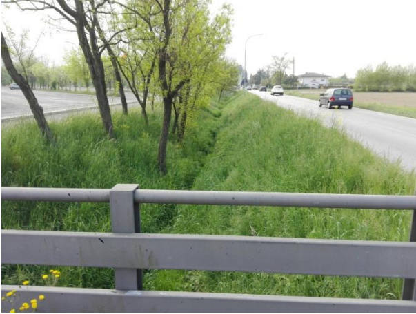
Foto 08029. Capofosso lato nord via Cendon.
