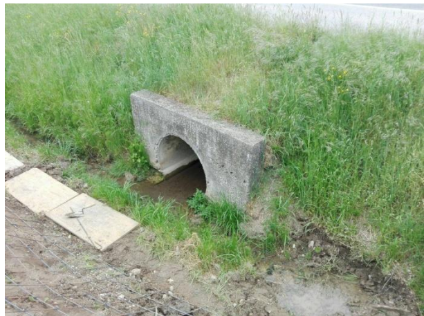
Foto 08206. Attraversamento di via Pozzetto dei fossi provenienti da Nord verso il Pentia Musestre.
