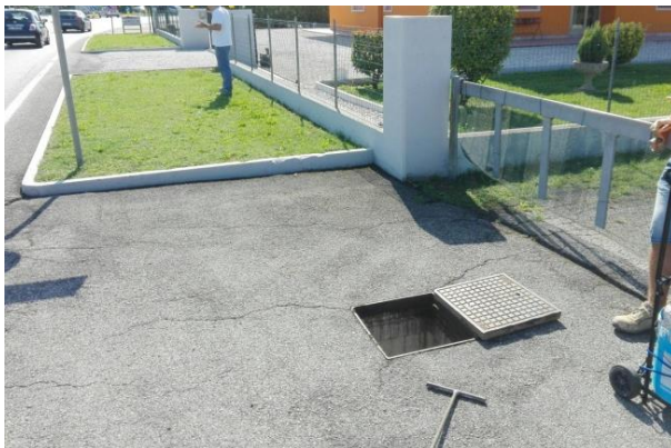
Foto 14095. Chiusino pozzetto presso il civico 20.
