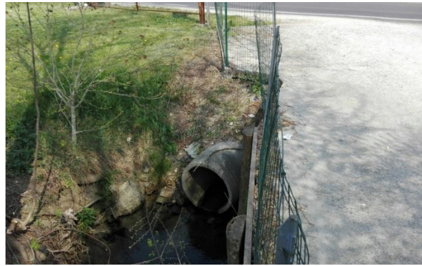
Foto 04120. Inizio capofosso di via Tiepolo. Scarico dell'abitato.
