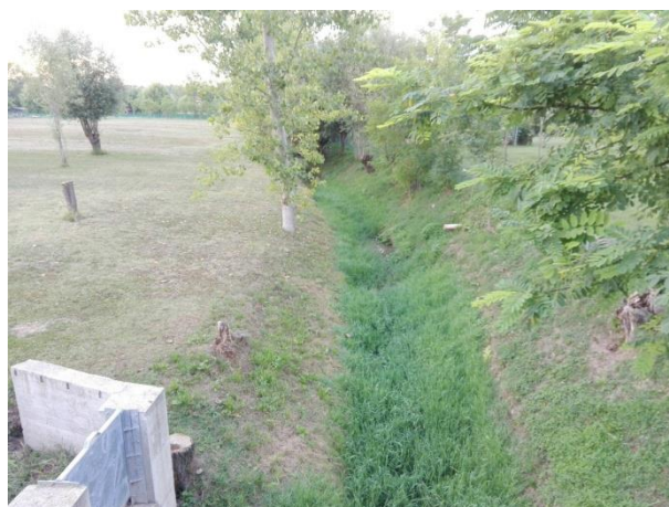
Foto 11038. Canale Pentia a monte dell'attraversamento di via Pozzetto. Nel lato destro, manufatto di regolazione dell'immissione del capofosso di Foto 11034.
