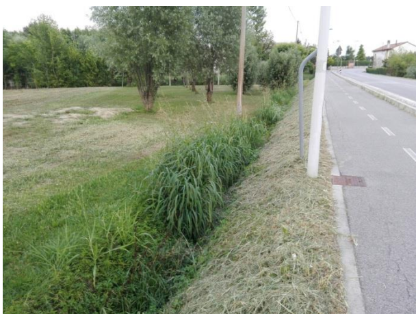
Foto 11034. Capofosso lungo via Pozzetto lato nord.
