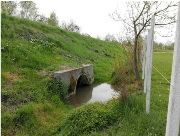
Foto 06211. Attraversamento S.R.89 lato Nord.
