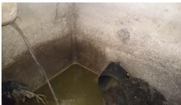
Foto 16043. Condotta verso impianto di sollevamento.
