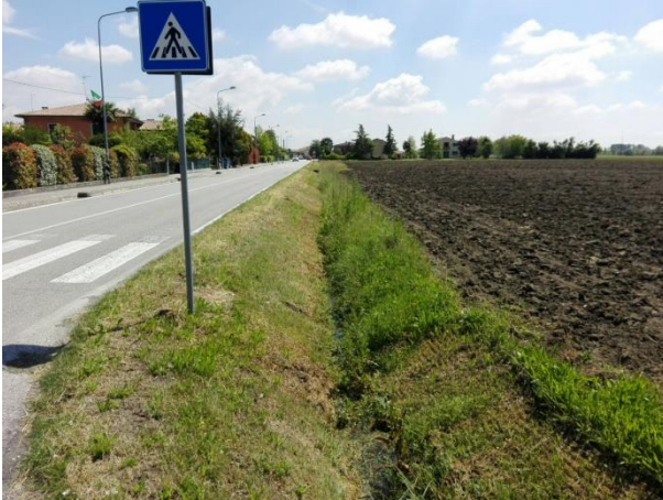
Foto 09074. Capofosso lato sud di via Pozzetto.
