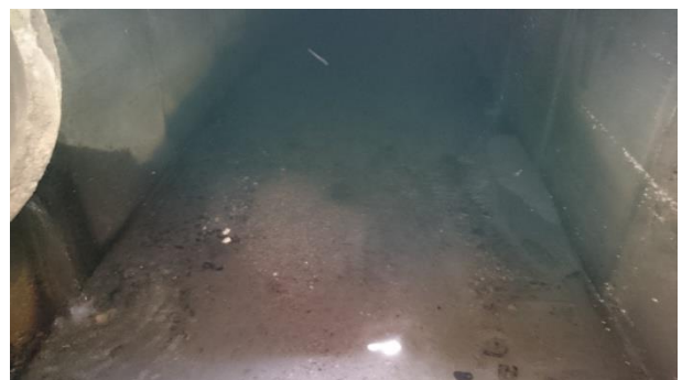
Foto 15047. Scatolare proveniente dall'area commerciale.
