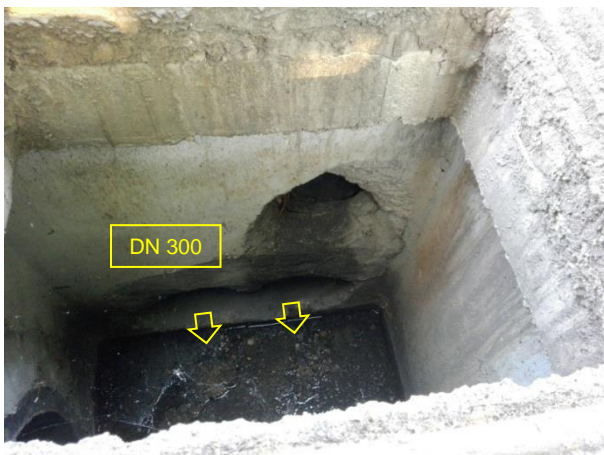
Foto 13002. Pozzetto lato est.
