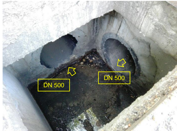
Foto 13001. Pozzetto lato est.
