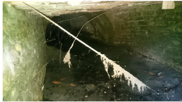
Foto 17049. Manufatto di attraversamento.
