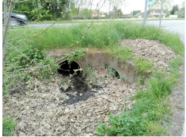
Foto 06315. Attraversamento S.R.89 lato sud.
