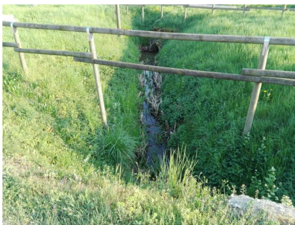
Foto 05315. Capofosso via Claudia Augusta lato ovest. Attraversamento incrocio con via Malviste.
