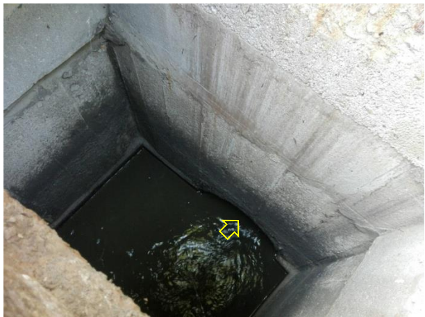
Foto 13028. Manufatto di sfioro lato sud.
