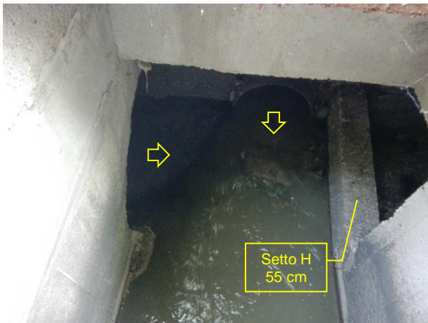
Foto 13029. Manufatto di sfioro lato sud.
