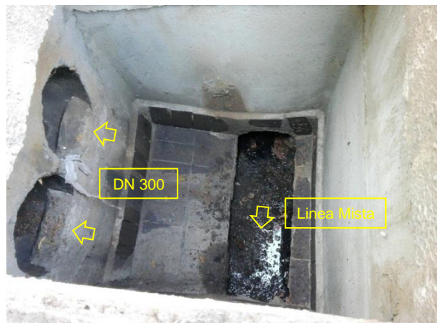
Foto 13005. Manufatto di sfioro.
