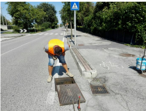
Foto 14147. Chiusino pozzetto di attraversamento.
