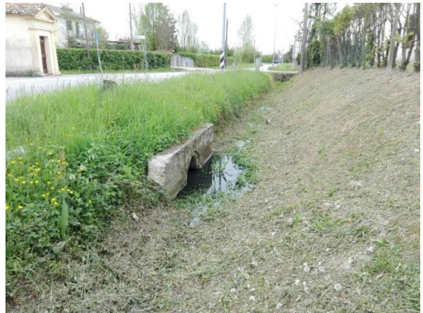
Foto 06252 Attraversamento via Montiron.
