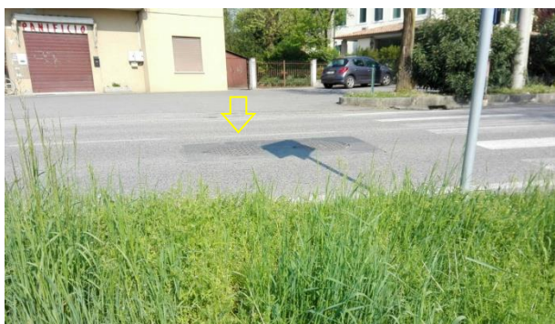
Foto 05200. Chiusino pozzetto di sfioro.
