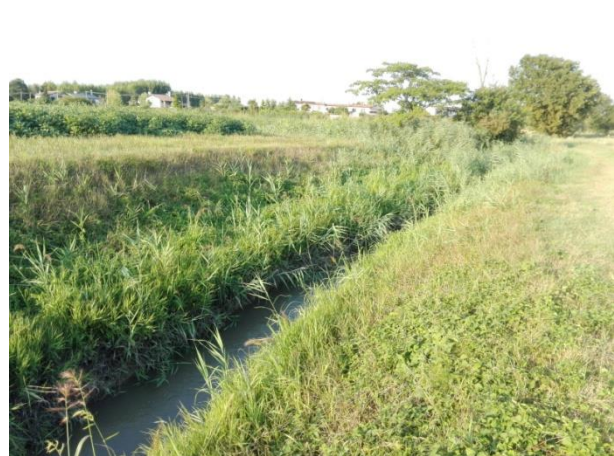
Foto 13277. Canale Pentia Sile a valle della diversione del canale Pentia.
