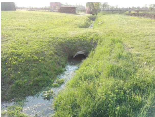
Foto 05295. Canale Pentia a monte della confluenza del capofosso proveniente da via Malviste
