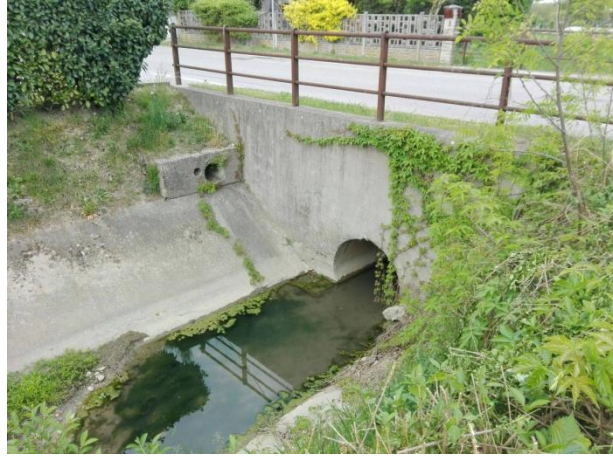
Foto 08173. Canale Pentia Musestre Nord. Attraversamento via Pozzetto.
