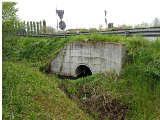
Foto 05022. Scarico della rotonda nel capofosso.
