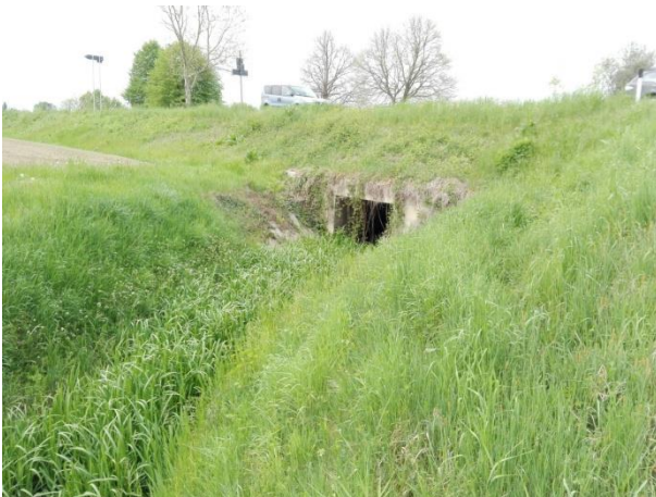
Foto 06193. Attraversamento della S.R.89 del Montiron, lato sud.
