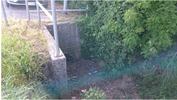
Foto 15086. Ingresso del fosso lungo la S.P.64 nella linea meteorica di via Belvedere.
