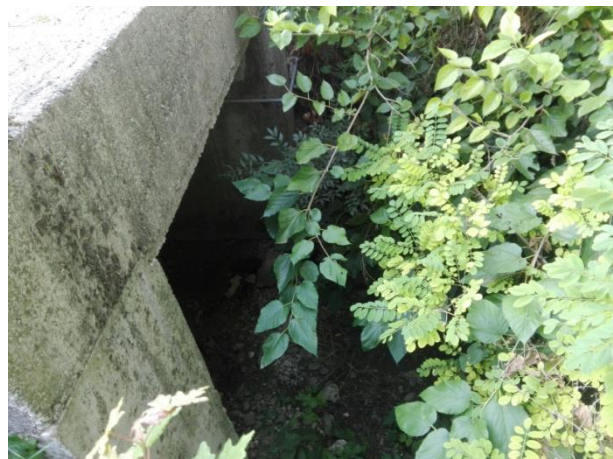
Foto 13296. Attraversamento di via Claudia Augusta.
