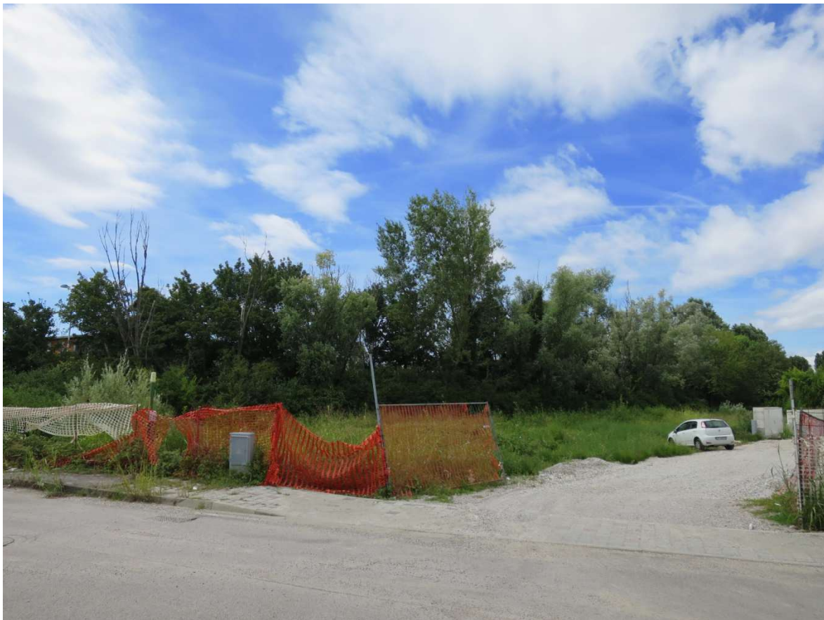
Foto 2.1 – Vista dell'ambito di intervento da est
