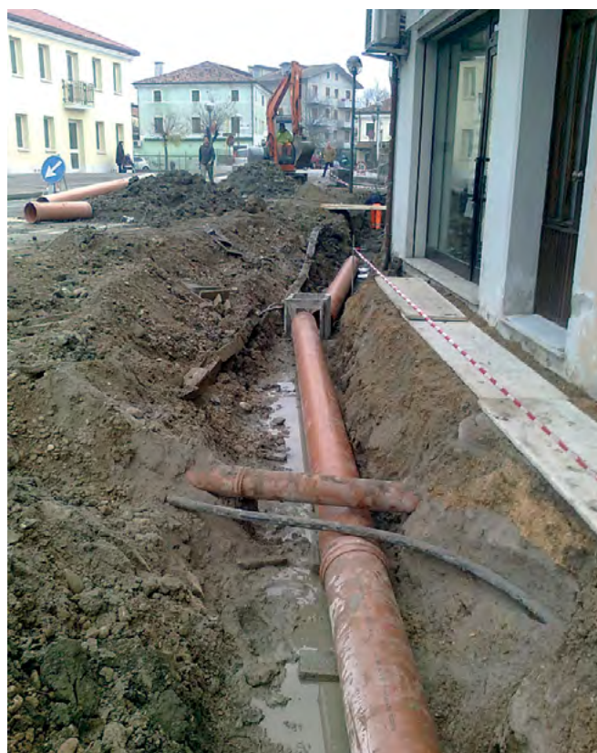
Lavori di realizzazione della condotta
