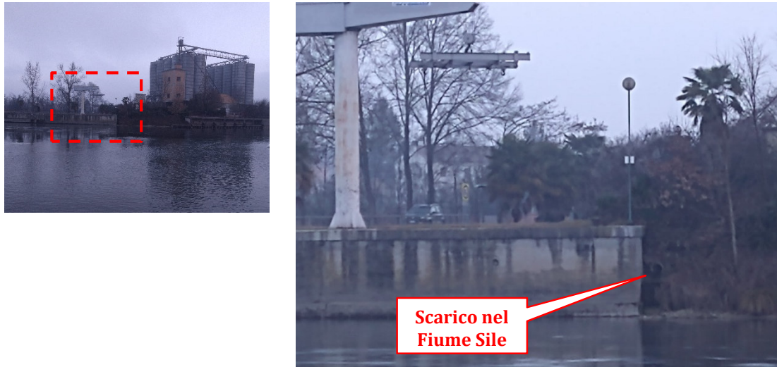
Fig. 4.1: Scarico nel Fiume Sile del tombino lungo Via Alzaia
